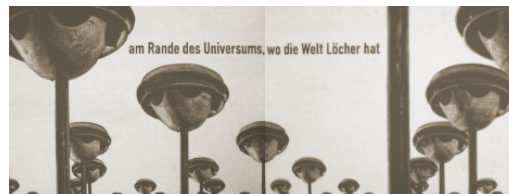
Als Rapport montierte Telefunkenlautsprecher für den Außenraum aus den 30er Jahren (im Volksmund »Goebbels-Plärre«)
