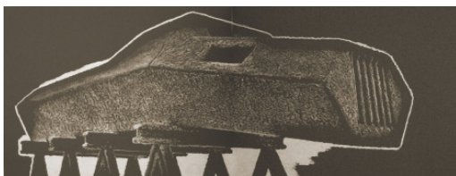
Gepanzerter Aufbau/Karosserie für das Halbkettenfahrzeug eines Militärfahrzeugs der Fa. Westfalia (1943–45); gezeichnet nach einem mit Plüschstoff bezogenen Modell (MDF Mock-Up)
